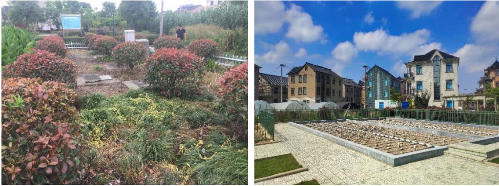
图 4-1 污水处理设施改造前后对比图
